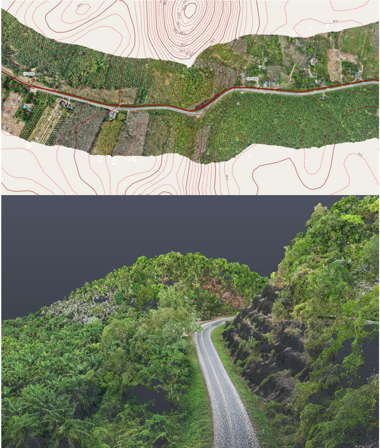
รูปที่ 5-6 พื้นที่ที่ 2 ลักษณะภูมิประเทศเป็นเนินเขาชัน
